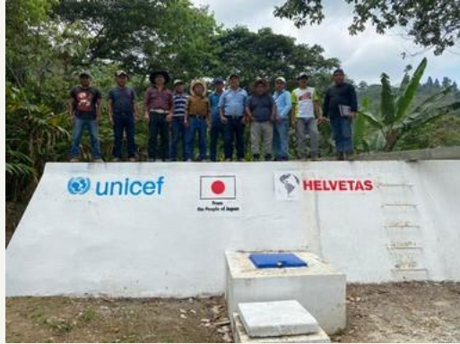
Tanque de distribución y sistema de desinfección
