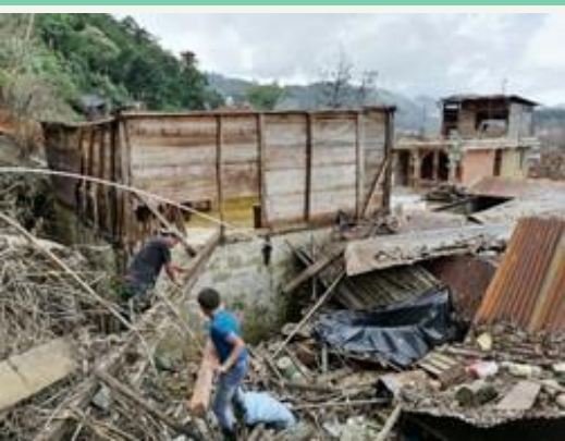
Daño en la infraestructura de las viviendas
