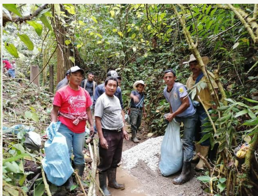
Acarreo de materiales para la rehabilitación
