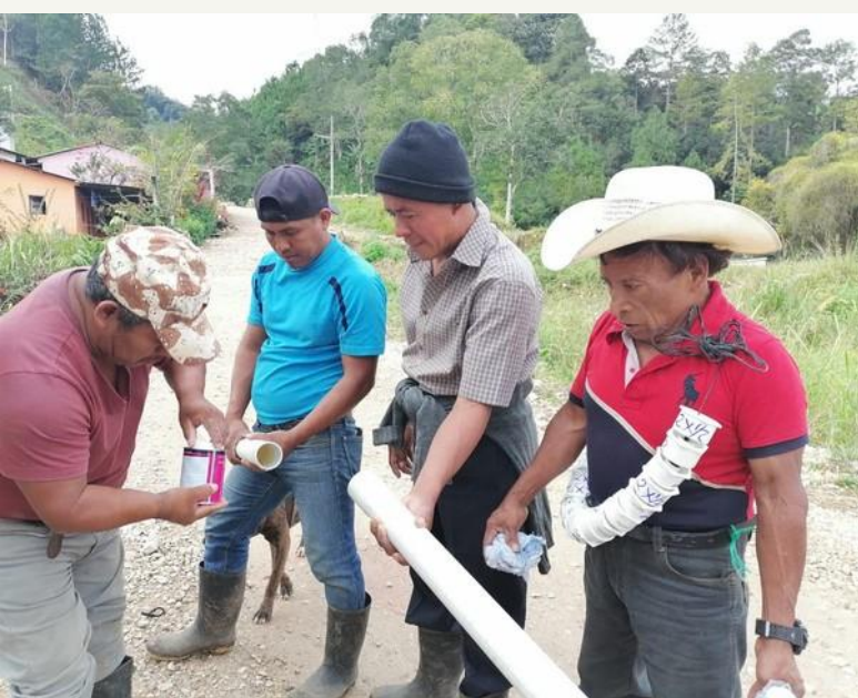
Miembros del Comité de Agua en la instalación de tubería de PVC
